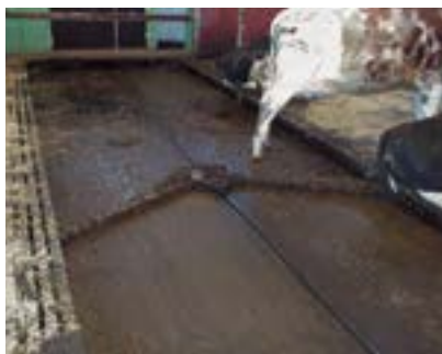
Figura 13. El pasillo central de este establo de Suecia tiene un piso de goma y una barredora mecánica que recorre ambas vías del pasillo. Obsérvese que la parte de atrás del pasillo está equipada con listones, los cuales también están cubiertos con goma. (Cortesía de C. Bergsten.)
