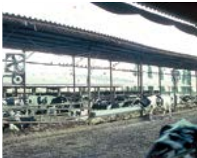
Figura 19. En climas tropicales (tal como en este tambo localizado en Israel) los establos tienen techos altos, ventiladores de enfriamiento y, en algunos casos, atomizadores de agua, a los efectos de ayudar a disminuir la temperatura corporal de las vacas.
